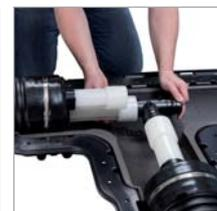
Без задержек наденьте расширенную трубу на штуцер фитинга до упора. Держите трубу до тех пор, пока она не обожмет фитинг. Готово!
